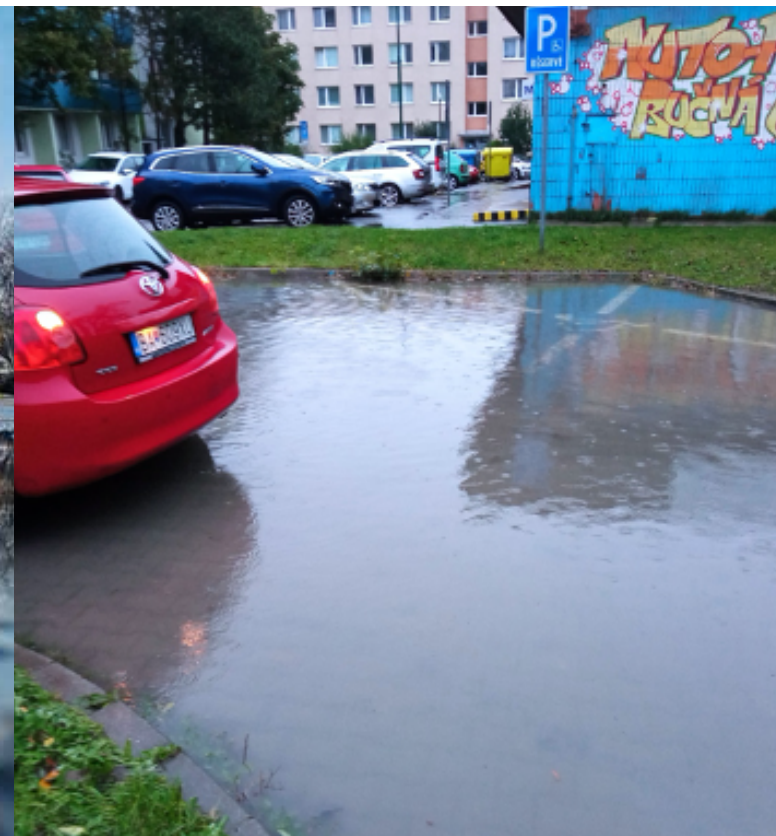
Zrážkovú vodu zo spevnených plôch a chodníkov je potrebné vyspádovaním viesť do plôch zelene Foto: Zuzana Hudeková
