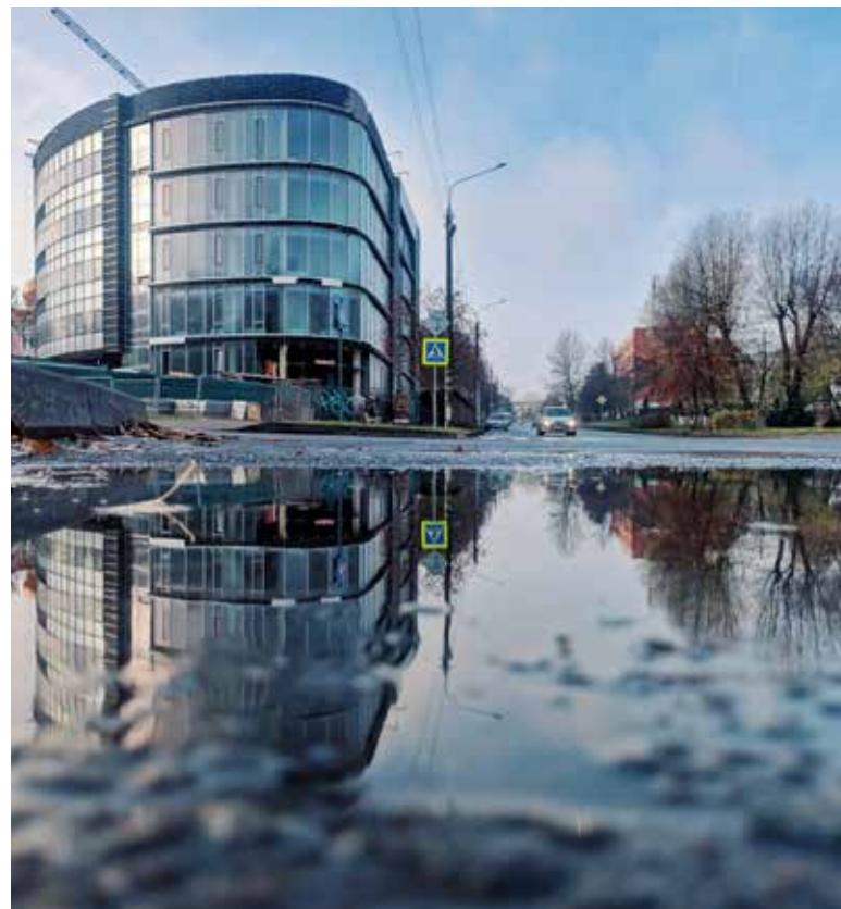
Pri nedostatočnom odvodnení sa zrážková voda akumuluje a vytvára rozsiahle kaluže Foto: Pexels
