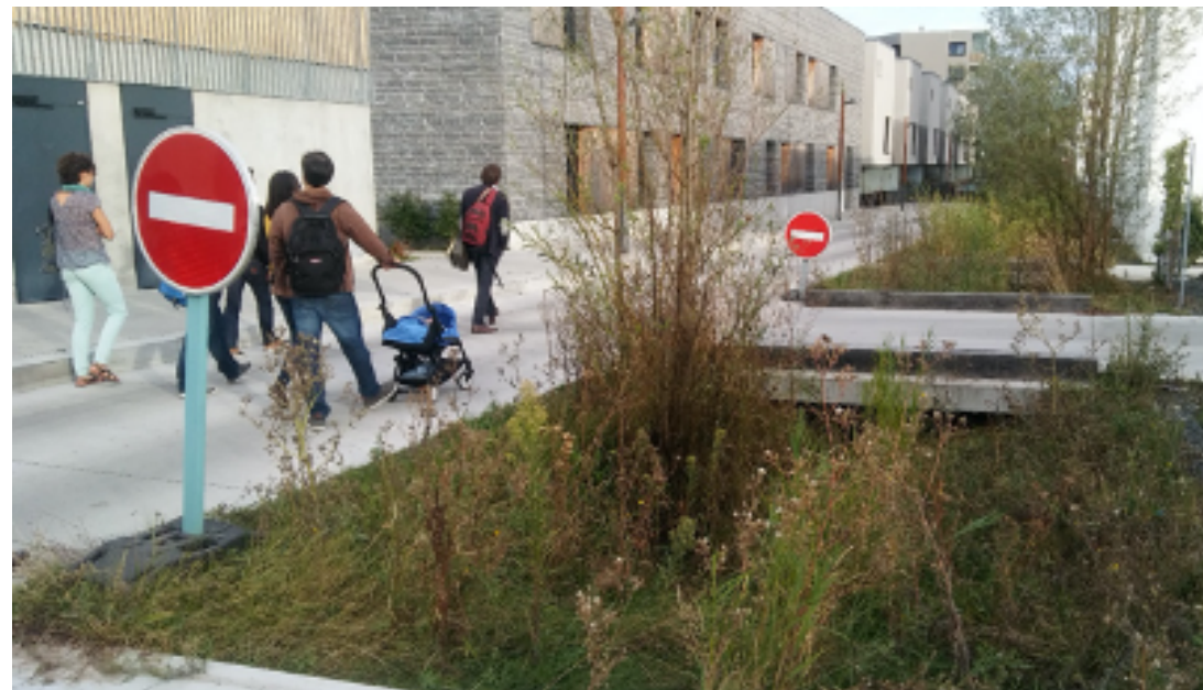
Riešenie odvodnenia spevnených plôch komunikácií do vsaku v Nantes (Francúzsko) Foto: Zuzana Hudeková
