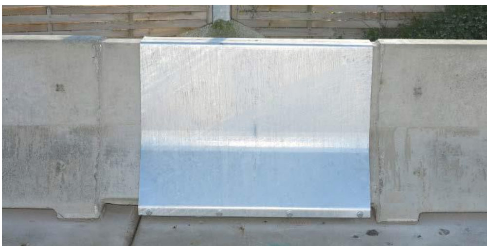
Obrázok 59 – Zvodidlo DB 120S-A, pohľad na dokončenú dilatáciu
