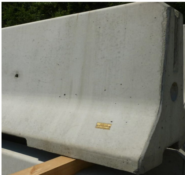
Obrázok 10 Umiestnenie kovového alebo plastového štítku na pohľadovej strane dielca
