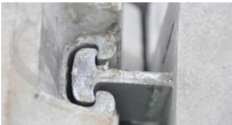
Obrázok 1 – Zámok zvodidla DB 120S 6m typu T280E zabudovaný v čelách dielcov
